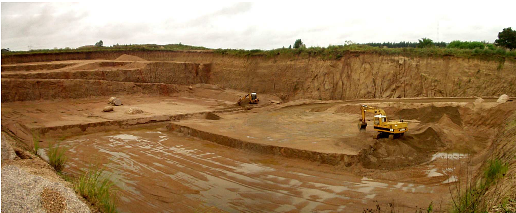
Figura 11 : Vista panorámica de una cantera en la zona del A° Colorado. Nótese la “prolijidad” del laboreo, con frentes y pisos activos y otros en preparación. Sin material derrumbado y piso inferior seco. Además el perímetro de la cantera es una zona más baja a manera de canal y con caída hacia la esquina superior derecha de la imagen, donde existe una especie de sumidero y está instalada la bomba de desagüe.
