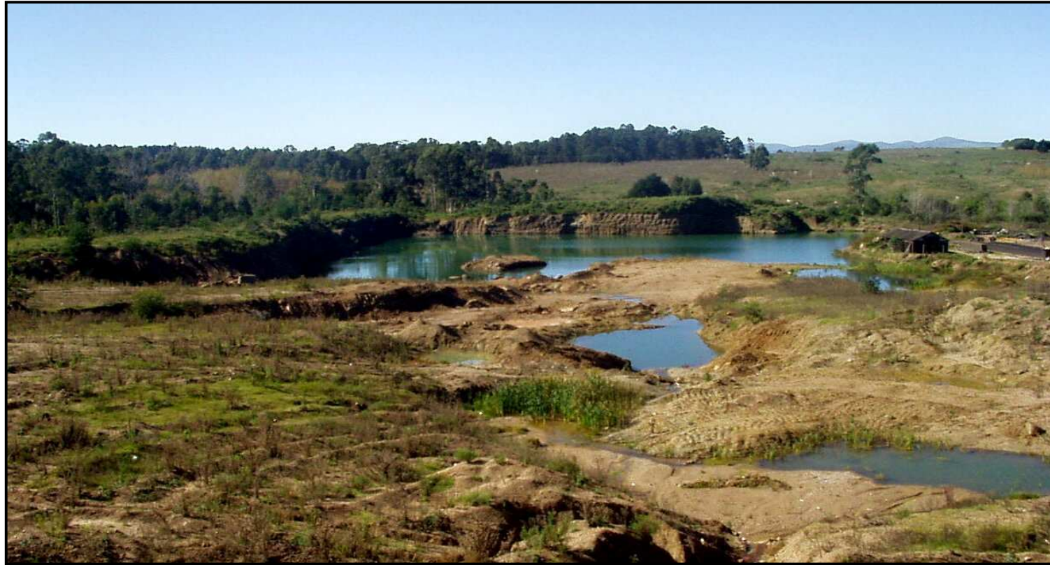
Figura 13 : Cantera abandonada de Balasto, en la zona de Capilla Cella. Ubicada en el extremo occidental del Granito de Soca , en una facie granuda a porfiroide, alterada. Obsérvese la irregularidad de la extracción debido a las frecuente variación en el espesor del manto de alteración del granito.
